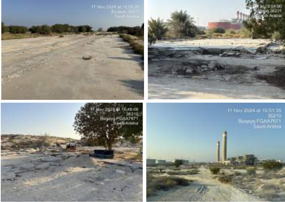
الشكل 5-10: أساسات خرسانية متبقية وطرق مدكوكة ومخلفات هدم في موقع المشروع
