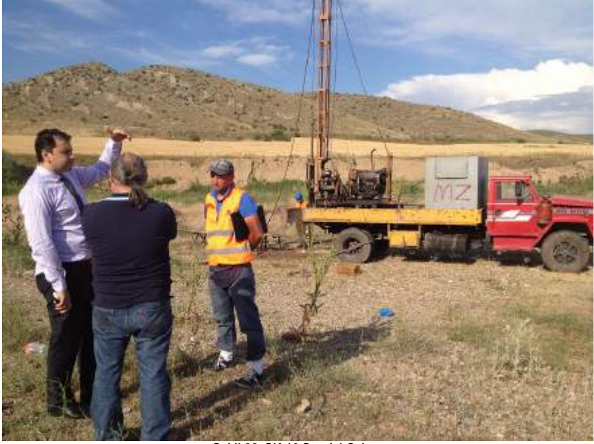
Şekil 32. SK-10 Sondaj Çalışması
