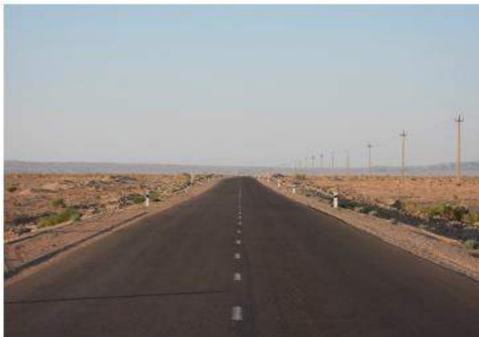
Рисунок 2-22 Вид на внешнюю асфальтированную дорогу, соединяющуюся с автомагистралью A380
