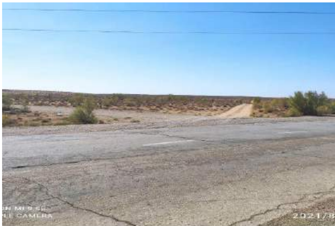
Рисунок 11-5 Вид на подъездную дорогу, соединяющую Площадку Проекта с шоссе A379
