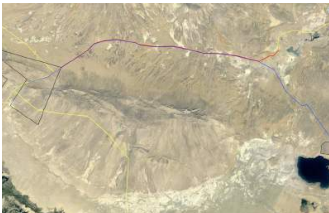
Рисунок 2-10 Расположение асфальтированной дороги по отношению к маршруту ВЛЭП (синий цвет - маршрут ВЛЭП, красный - асфальтированная дорога)
