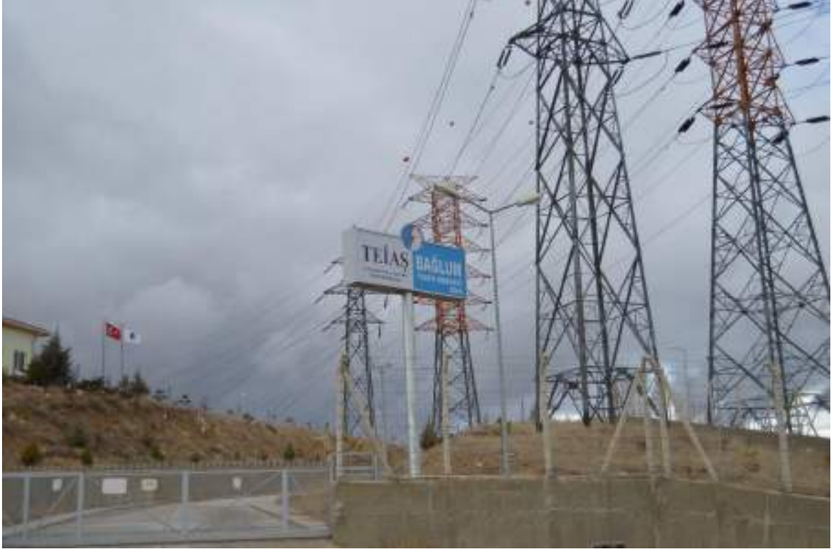
Şekil 5. Proje Alanı Fotoğrafları (Bağlum Trafo Merkezi)
