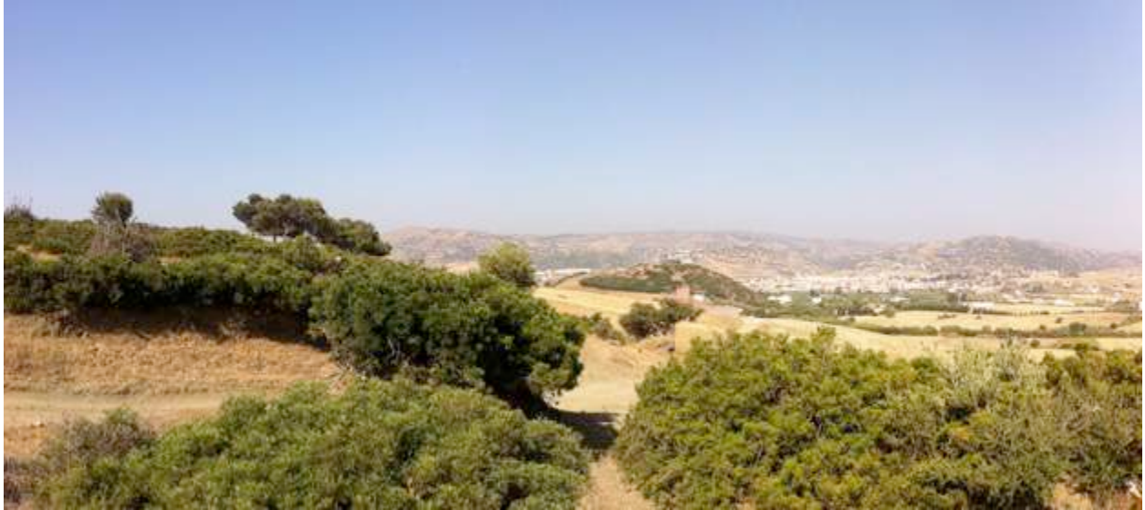
الرقم 9 - 5 خط كهربائي ممر أبراج 68-70
