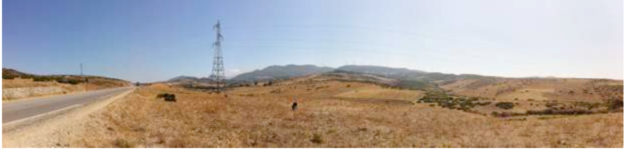
الرقم 9-20 خط كهربائي ممر أبراج 13/10 ، ، وPL القائمة.
