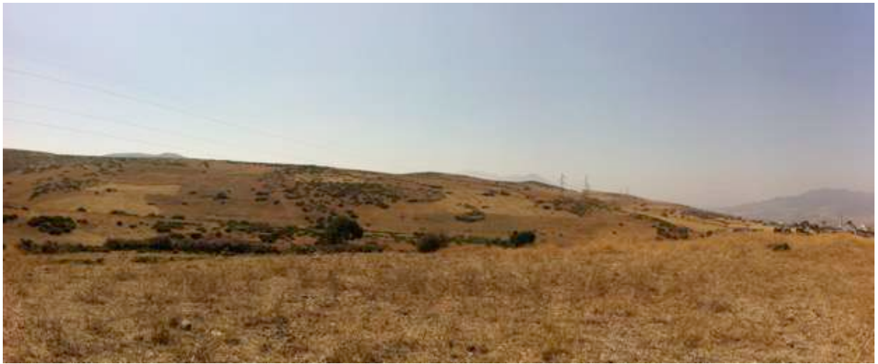
الرقم 9-21 خط كهربائي ممر أبراج 10/08 ، ، وPL القائمة.
