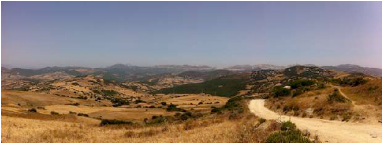
الرقم 9 - 6 خط كهربائي ممر أبراج 68-75
