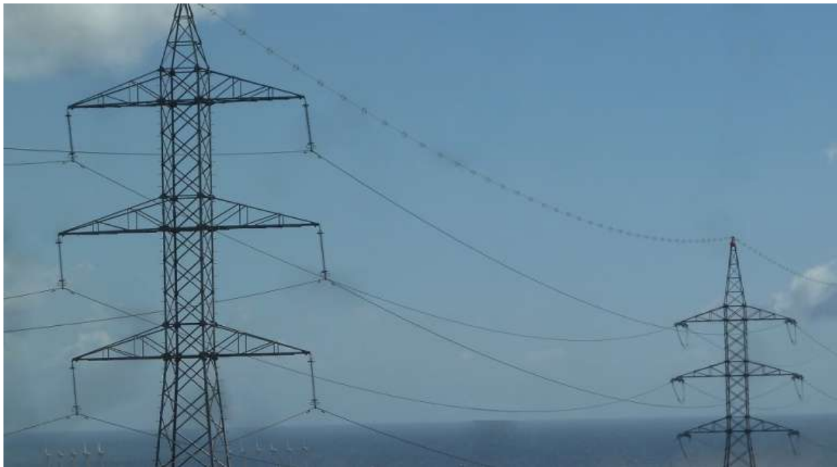
Figure 5-3. Des exemples de marqueurs/dispositifs de déviation pour les oiseaux installés en Espagne.
